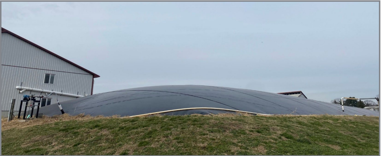
Digestor anaeróbico de laguna cubierta en Kilby Farm en el condado de Cecil, MD. Foto: Amro Hassanein
