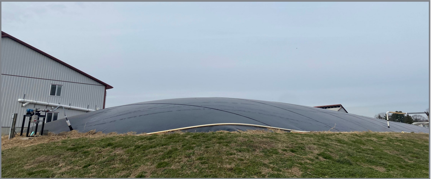
Yon basen dijestè anayewobik ki kouvri nan Kilby Farm nan Cecil County, MD. Foto: Amro Hassanein
